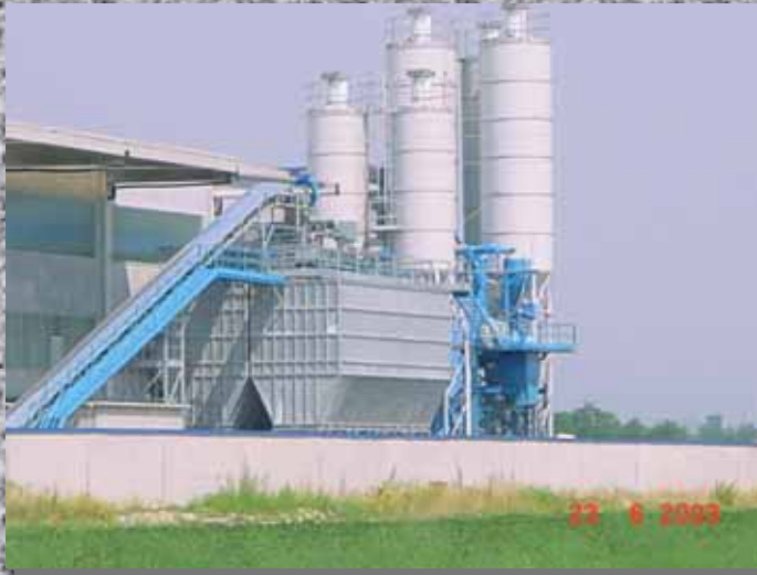
Impianto per la produzione di pannelli prefabbricati.
