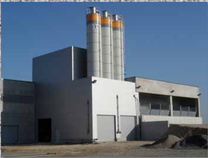
Impianto per la produzione di blocchi.
