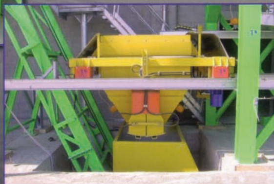
Vagonetto in fase di scarico inerti dosati nello skip del mescolatore.
