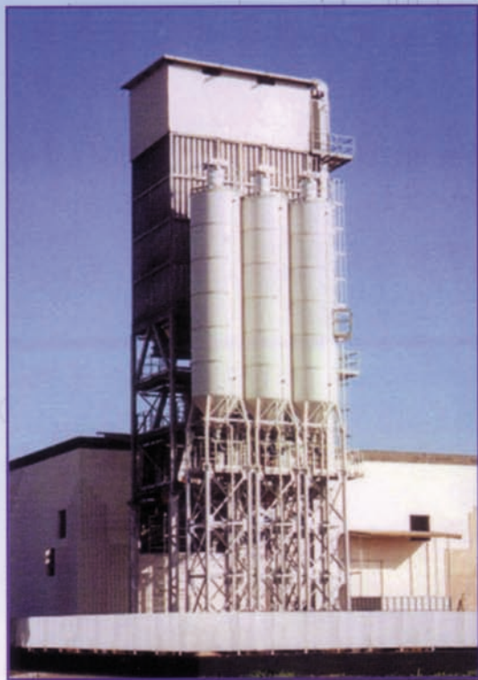
Impianto a torre 8 inerti 400 m 3 totali.
