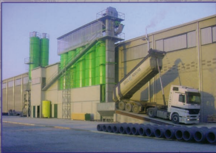
Caricamento con tramoggia primaria, elevatore a tazze verticale e distribuzione nelle tramogge di stoccaggio con nastri distributori su binari.
