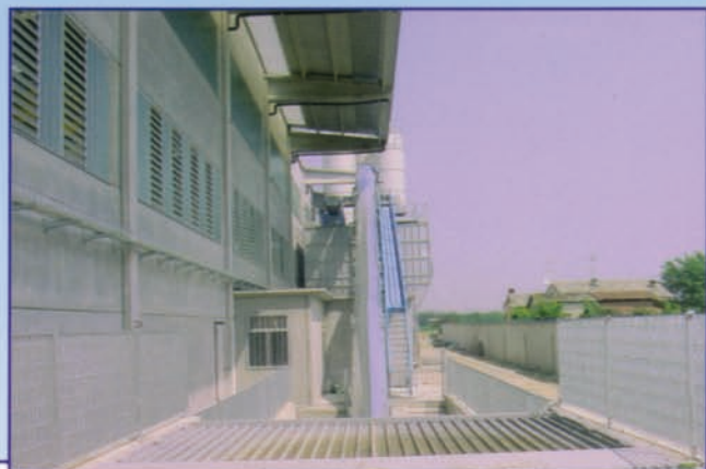
Tramoggia primaria con griglia di sicurezza.
